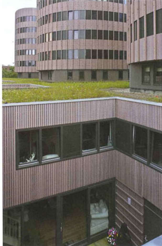
Om ook in de patiowoningen zon en licht te vangen, hebben ze diepe insnijdingen die half onder de grond eindigen.
