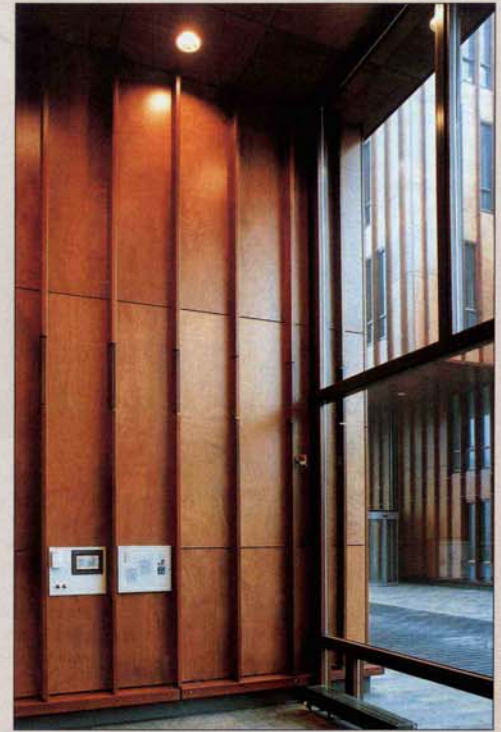
▷ De details voor de stijlen (binnen en buiten) heeft het architectenbureau zelf ontwikkeld, ze zijn er voor onderhoud af te schuiven.
